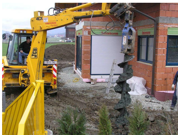
Rysunek 48. Wiercenie otworu pod kosz energetyczny
