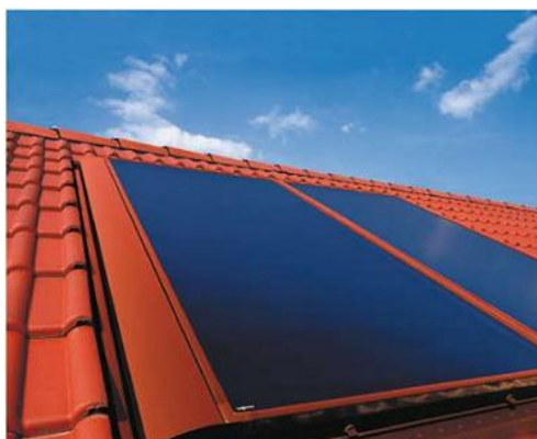
Rysunek 18. Kolektor płaski Vitosol 200-F zintegrowany z pokryciem dachu Źródło: www.viessmann.pl
